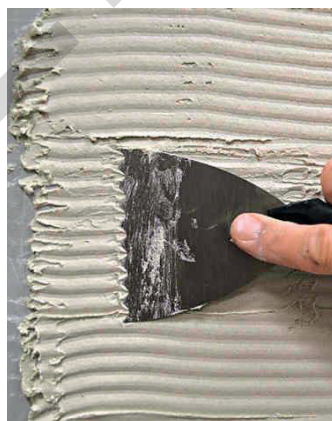
Провести зубчатым шпателем
